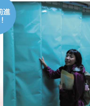
屋内退避所内の放射線防護カーテン (志賀町)
