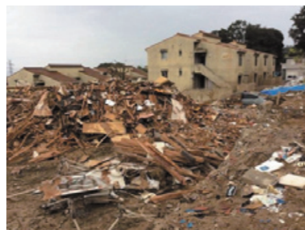
10.5広島市の土砂災害の様子
