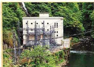
上寺津発電所
