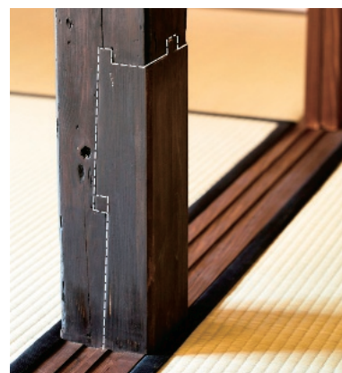
傷んだ部分を補修して使用
